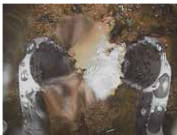
2号機での堆積物接触調査
